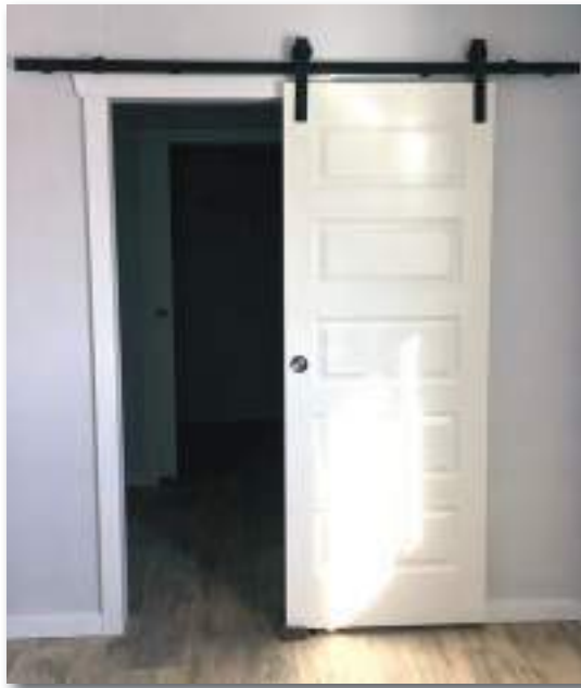
Barn Door Interior Door
